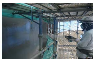
4. SW スプレー吹付け
