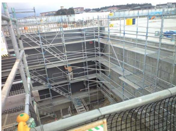
確実な防水が求められる地下構造物に「SW スプレー」塗膜を施すことにより、シームレスで強靱な保護層を形成します。
