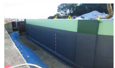
5. 完成躯体埋め戻し
