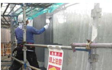
3. プライマー塗布
