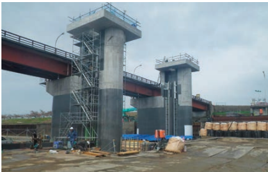
頭首工堰柱表面保護
