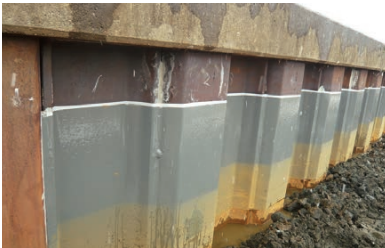
鋼矢板排水路
