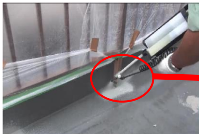
入隅を特殊ノズル(オプション)で施工
