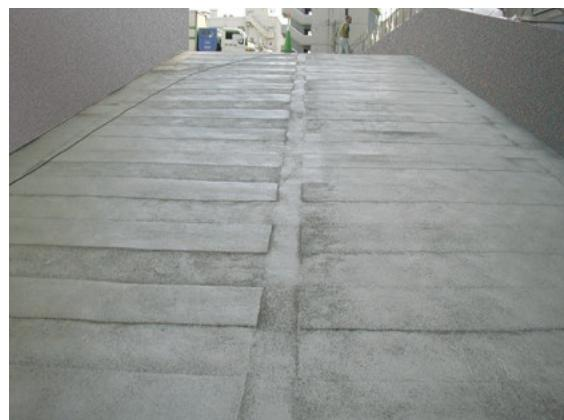
スロープやカーブなどに凹凸を設け、車両速度を抑制することで、防滑性を高めることができます。
