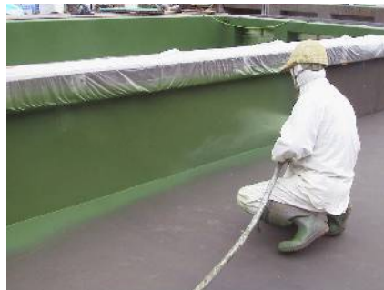
<防食層吹付施工中>
