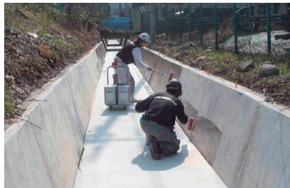
3. プライマー塗布
